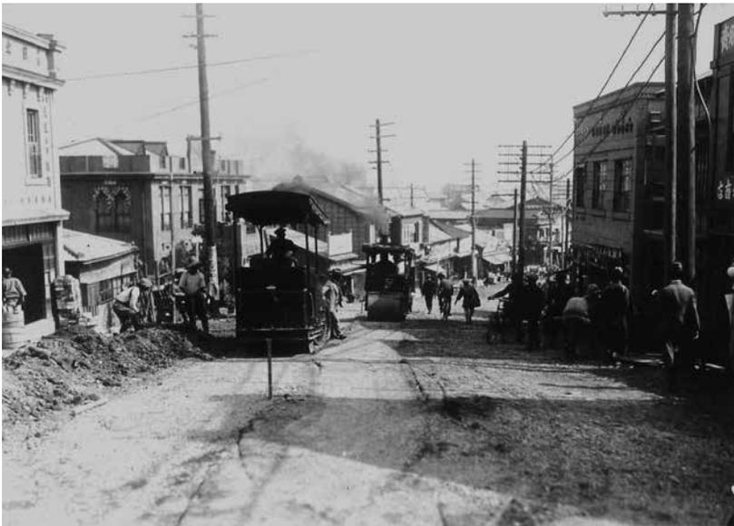
写真 4-2 震災後の横浜市内復興工事で働く三菱造船所製と思われるロードローラ。
