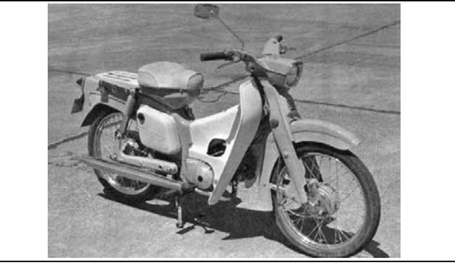
キセキペット50 PA50型 1961年 L1790mm WB1155mm VW71kg f3 <川崎>ME5 2c-49cc 4ps [I-1069/36.5.25] シリンダーヘッドは水冷式。
