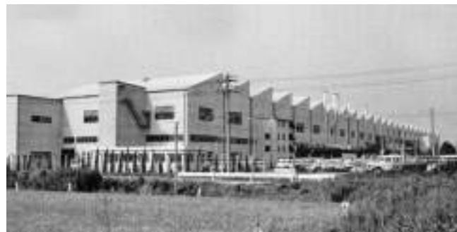
荒川車体工業本社第4工場は1979年9月に3度目の増築を行った。1階には40系の組み立てラインが設置され、2階には翌1980年から生産が始まることになっていた新型60系の組み立てラインが新設された。
