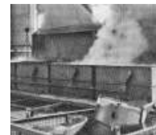
外山工場での金属表面ボンデライト処理作業（1957年）。
