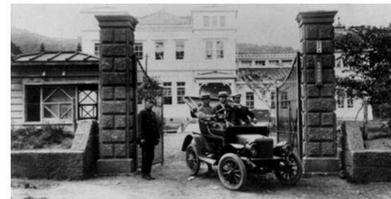
飛行機研究所。クルマは1910年ごろの英国製ローバー6hp、単気筒812ccエンジンを積む。
