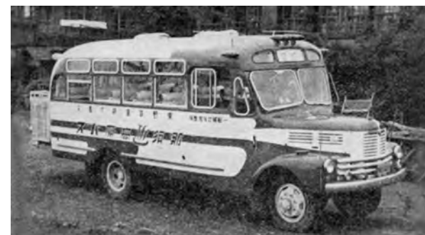
TS系 4輪駆動バス TSのシャシにBXのバスボディを架装している。
