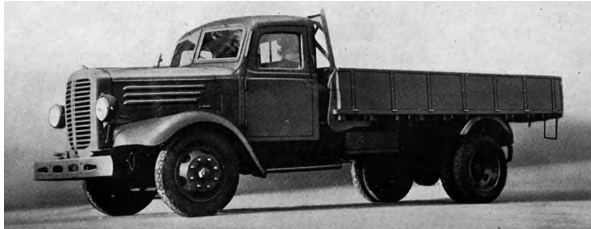
いすゞ TX80/60 5トン積 1941(昭和16)年10月完成 WB4000 [TX80]〈GA50〉G-SV-L6-4390cc 72hp [TX60]〈DA42〉D-予-L6-5103cc 85hp
