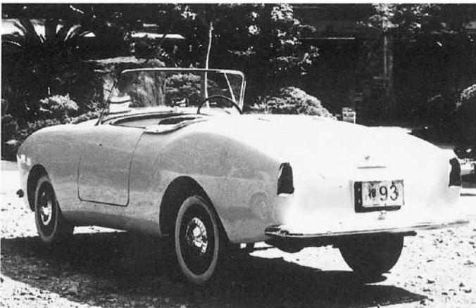
1957年ダットサン A80X <1957 Datsun A80X, considered as a prototype of Datsun Sport S211> ダットサン・スポーツS211発売の前年に作られた試作車で、明らかにそのプロトタイプである。ボディは既にFRPらしい。当時のダットサン210セダンと共通のハブキャップが、この車のシャシーの由来を物語っている。右手に見えるのは210の原型で1955年に登場した110で、背の高さはあまり変わらない。
