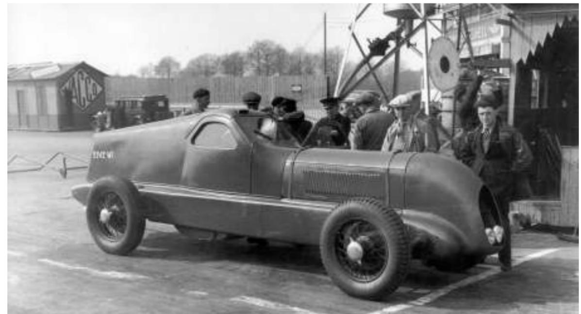
1934年の速度記録のスペシャル。ネルヴァスポールがベースで、レーシングカーのような低い車高ではないが、高度に空力的なスペシャルボディを載せている。とくにサイドビューはコードロン・ルノーのスピードレース機（35頁参照）を思わせるようなフォルムだが、その設計者のマルセル・リファールがこの車体をデザインした。コードロン社は1933年にルノー傘下に入っている。48時間平均約168km/hのほか、計3つの世界記録を樹立したが、コードロン・ルノーでも1930年代に速度記録を幾度も打ち立てており、そちらは400km/h、500km/hを謳っていた。
