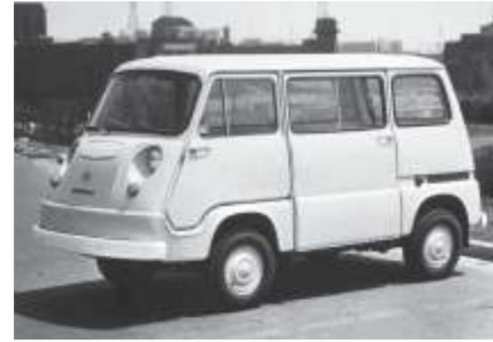
発売直後、雪道での挙動が不安定という苦情を受け、リヤの挙動を安定させるために燃料タンクも後方に移動されたため給油口の位置が変更された。こうした姿勢もユーザーが増える一因となった。
