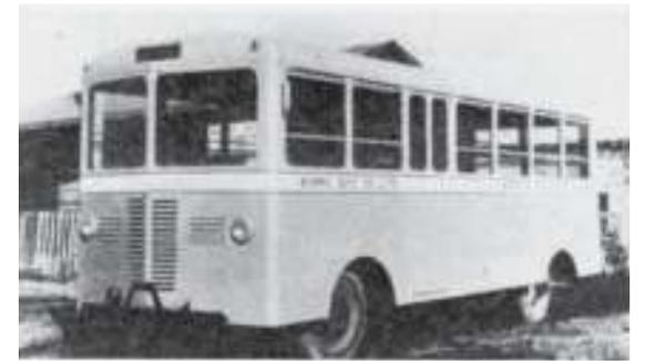
中島飛行機の解体後、富士産業の小泉工場ではバスのボディが生産された。これは航空機製作のノウハウが生かされたものといえる。
