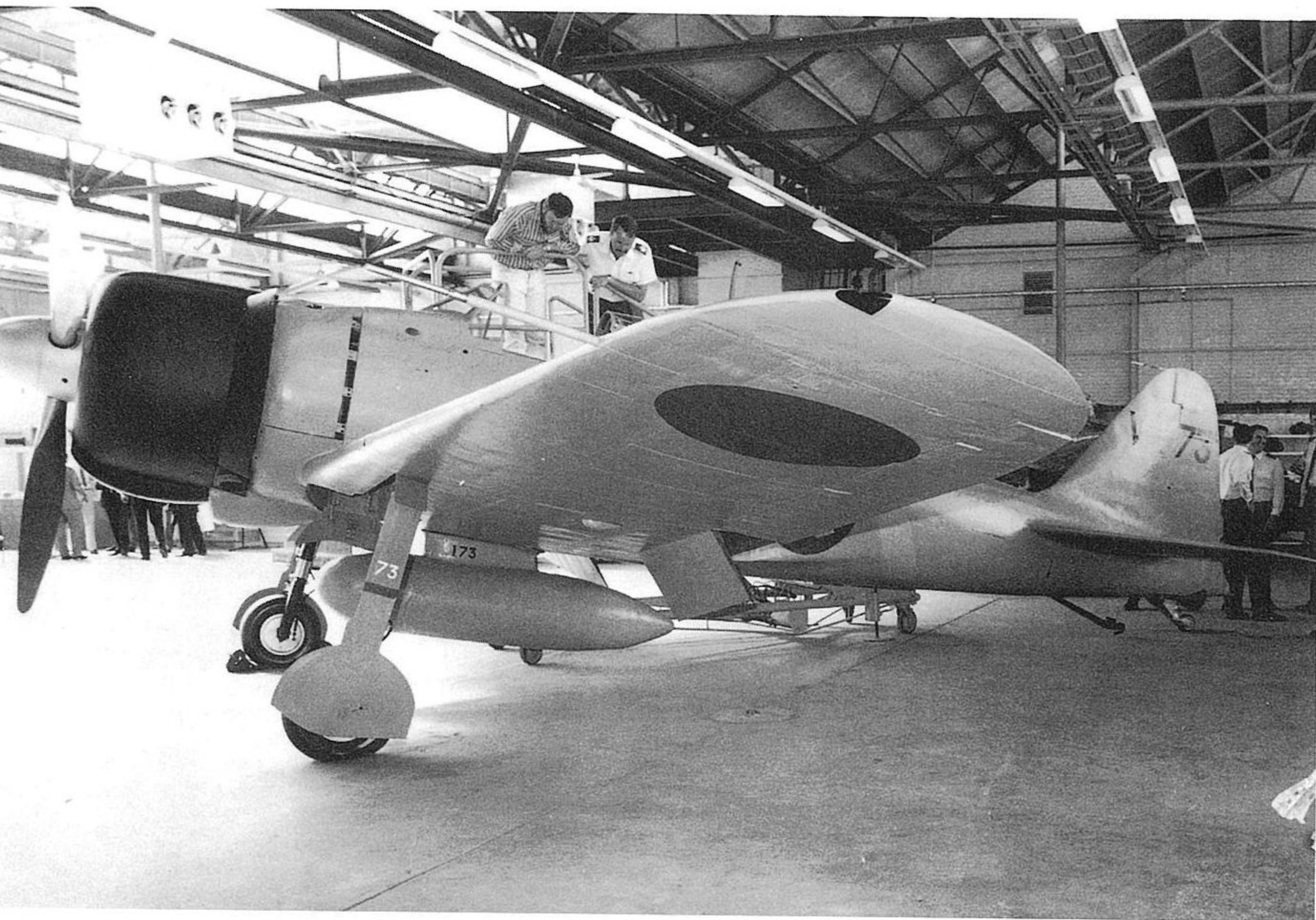
(1)キャンベラのオーストラリア戦争記念館の三菱A6M2「ジーク“Zeke”」(三菱零式艦上戦闘機)は、太平洋戦争初期の台南航空隊のマーキングで、当初の尾翼コードV-173が書かれている。本機は、1972年頃、ニューブリテン島のジャングルから回収され、ニュー・サウスウェルズ州ワガワガのオーストラリア空軍基地で修復工事が行われたものである。(M Clayton)
