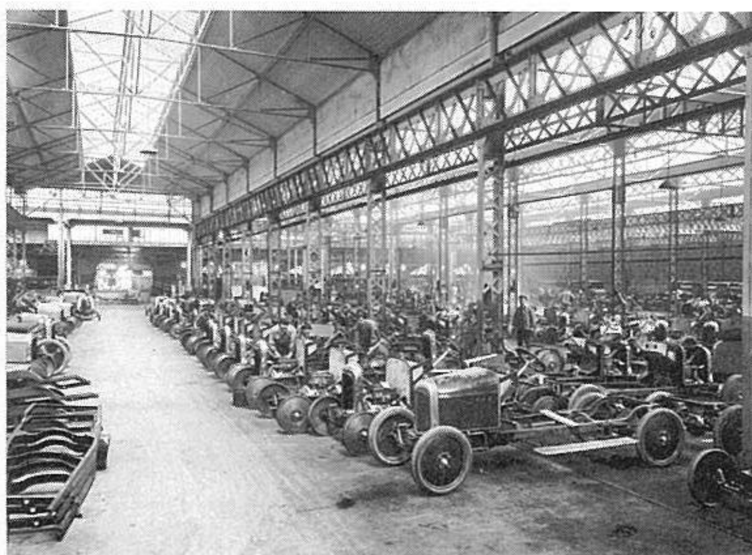
パリ15区のセーヌ河岸ジャヴェルに建設された工場で、タイプAが量産される光景。初期の頃なので、まだ手作業が多かった。
