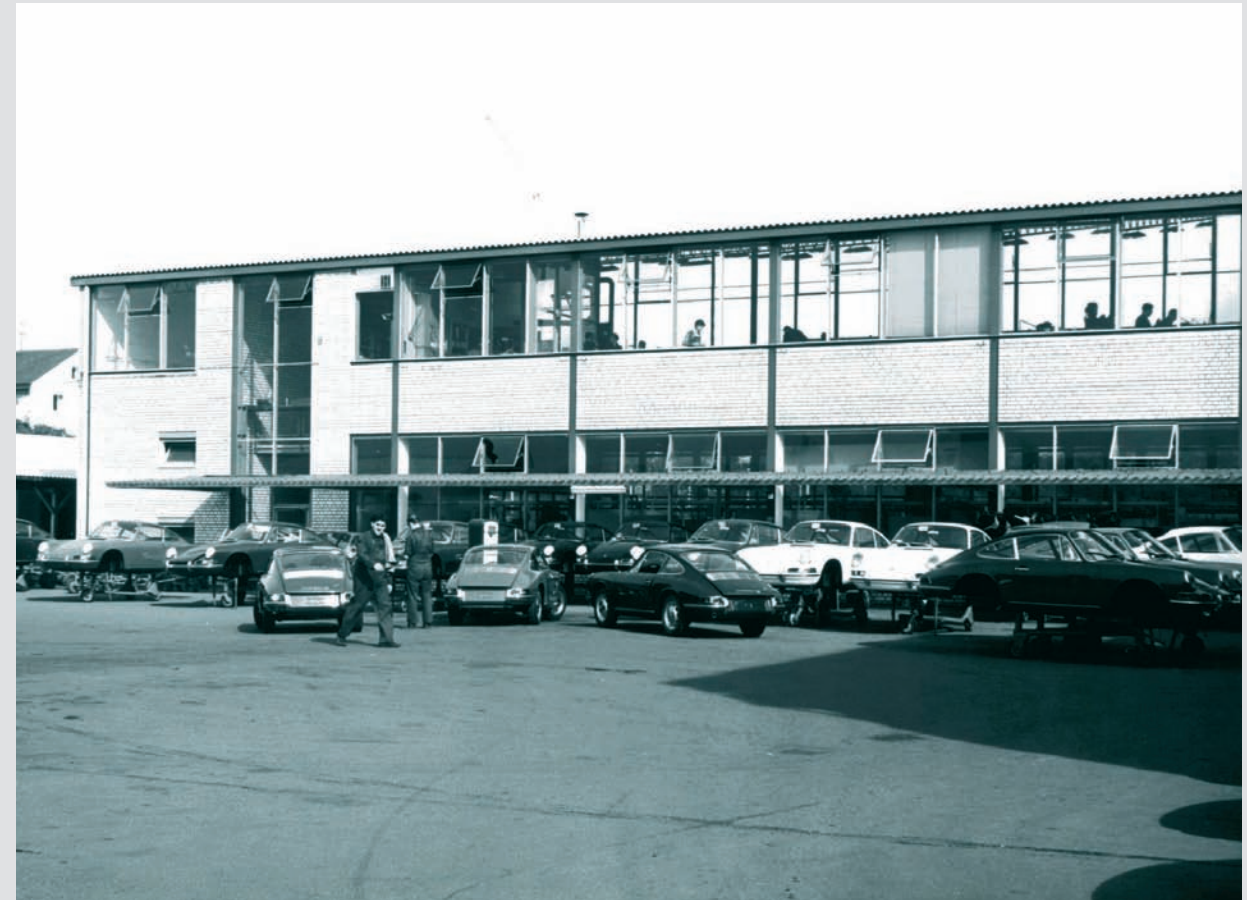
1965年に撮影されたポルシェ工場。発表後、生産が追いつかなかったほど人気を博した911の完成直前と思われるボディが、所せましの状態で置かれていることに注目。911の製造にあたっては、ボディ関連の外装部品が先に組み付けられてからサスペンションやエンジン関係の工程に移行し、生産されていたことがわかる
