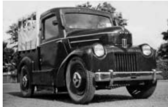
1947年4月に完成した最初の生産車EOT-47型。実験車にくらべモダンな顔つきとなった。ホイールキャップはオオタのものが使われている。
