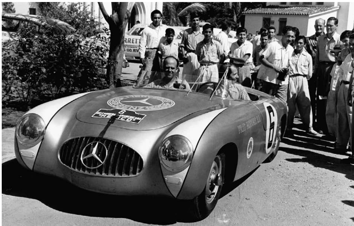
3位になった1台だけのロードスターボディの300SL、No.6(#0009/52) アメリカンドライバーのジョン・フィッチとドイツ人ドライバーのユーゲン・ガイガー組。彼らは、熱がこもるクーペよりも空気に曝されるロードスターボディを好んだ。ドライバーからの意見で1955年の300SLRは、原則ロードスターボディとなった。ヘッドライト周りの彩色はマットホワイト。
