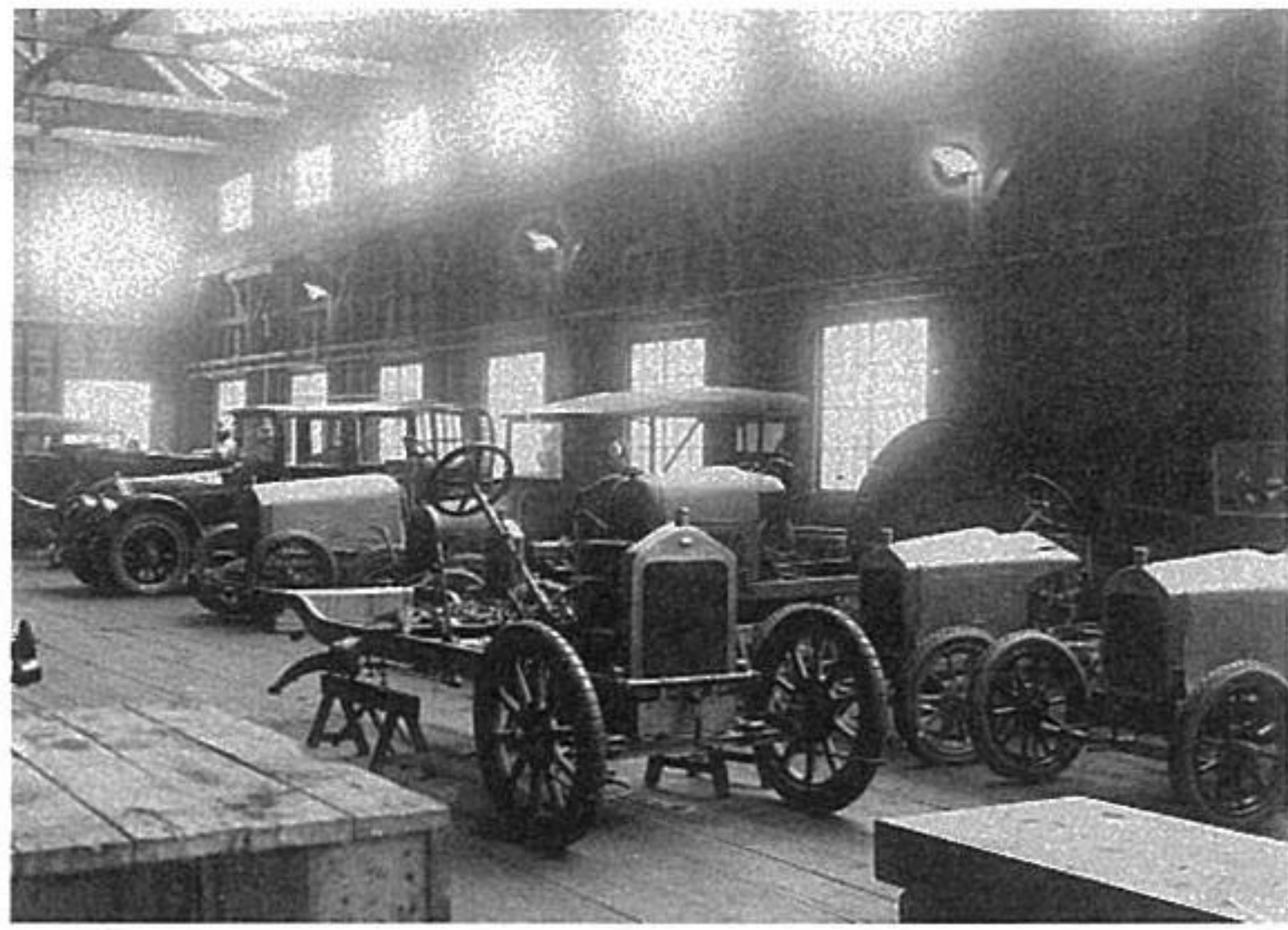
1920年ころの東京石川島造船所深川分工場で組立中のウーズレーA9型。
